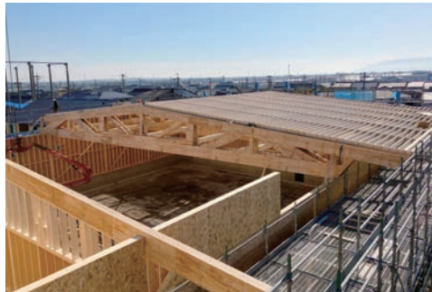
▲施工中の DE(⊕)RU
