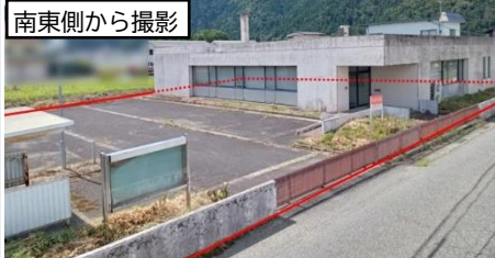
南東側から撮影
